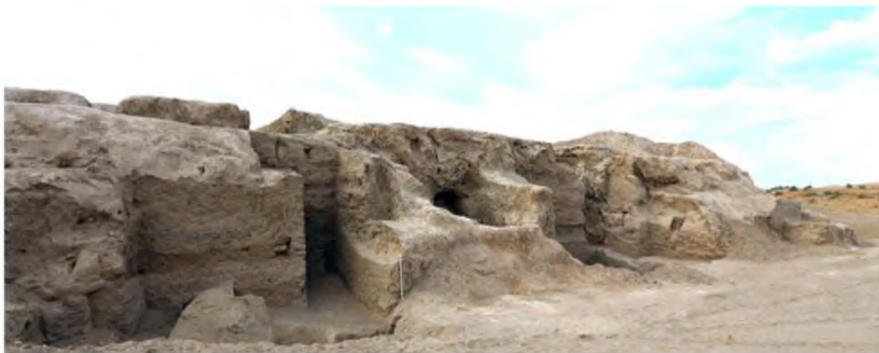
Рис. 6. Северо-западный сектор. Общий вид башен 1 и 2 и куртин
