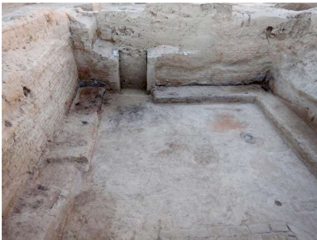
Рис. 9. Южная часть пом. 1, следы пожара
