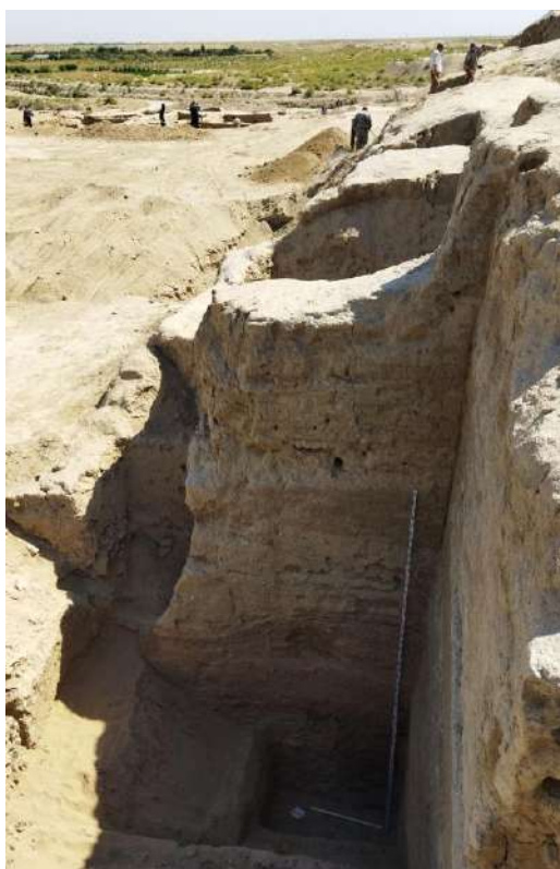
Рис. 2. Цитадель, северо-западный угол, шурф в куртине между башнями №1 и 2
