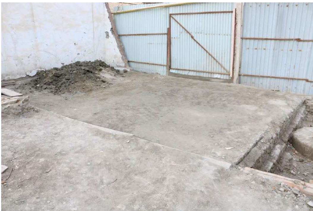
Рис. 15. Помещение 12. Вид с юга
