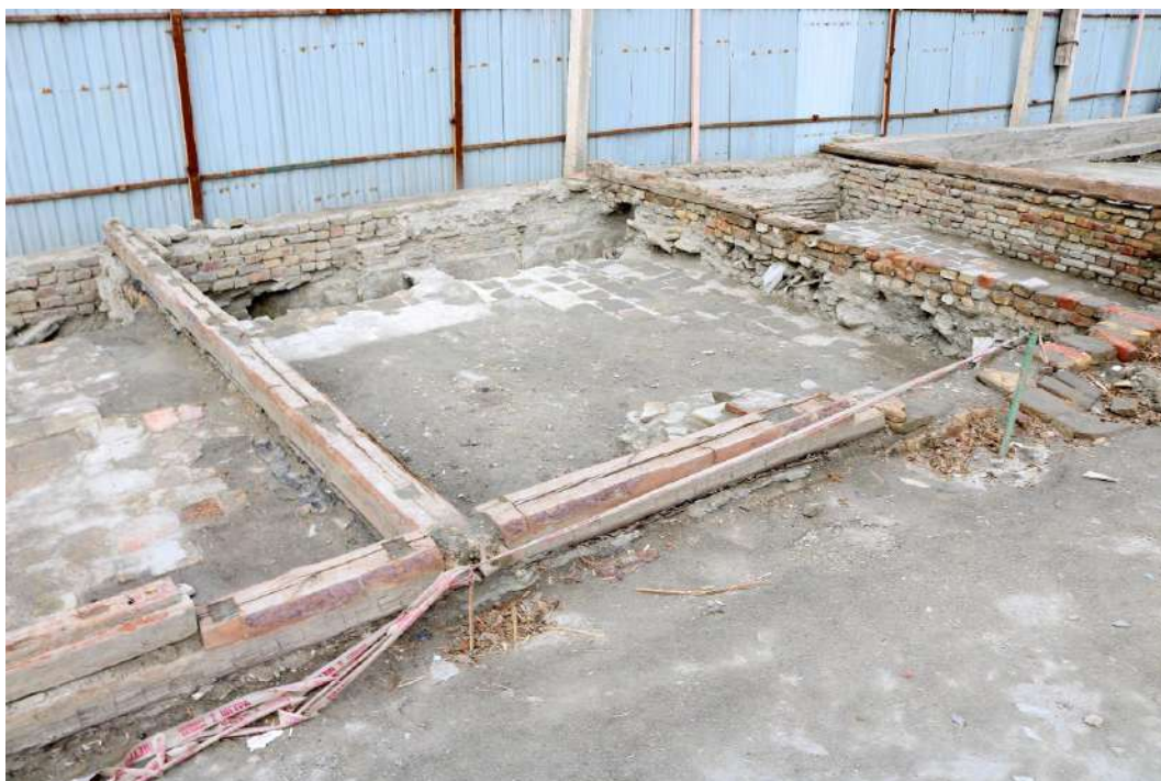
Рис. 12. Помещение 10. Вид с юга
