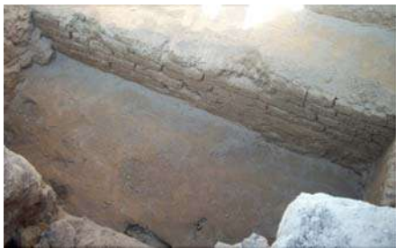
Рис. 3. Пом. 1. Уровень пола и суфа 1-го строительного периода
