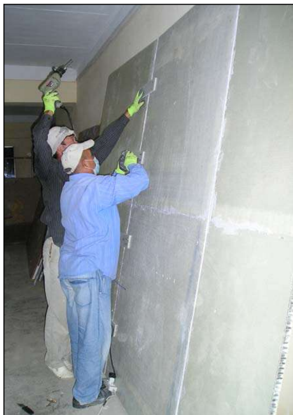
Рис. 4. Изготовление щита из
